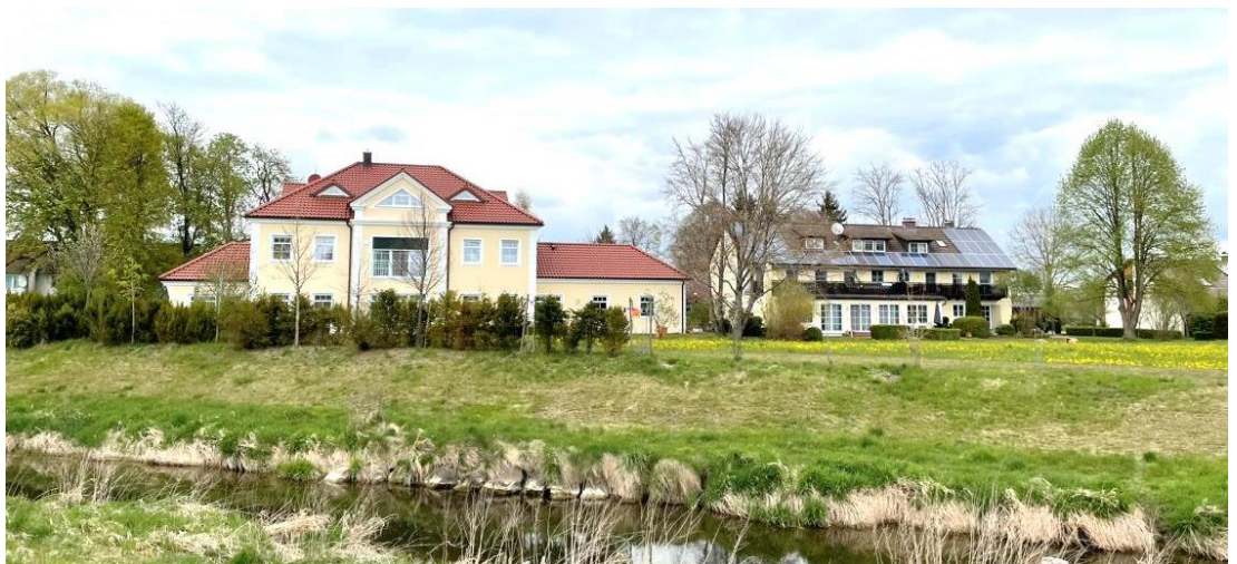
Abb. 5 Bebauung Windachstraße 1-3 von Süden mit Windachufer im Vordergrund
